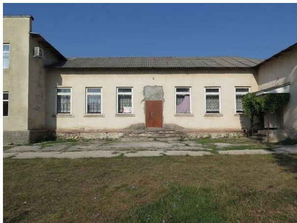
Inainte de reparatie
